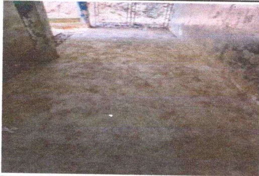
Foto 1: podemos observar que con este entortado hay demasiado polvo y lodo y los niños no pueden sentarse a jugar o convivir, por lo que vemos necesario ponerle piso ceramico para que tengan un ambiente digno
