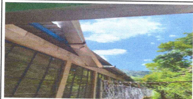
Foto 6: se procedera al cambio de canales pluviales que estan dañados
